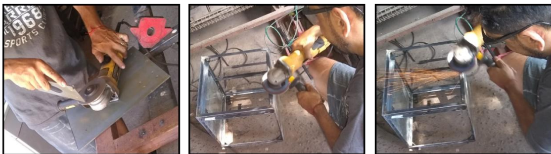
Ilustración 38. Realización de estructura inicial o esqueleto.
