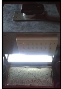
Ilustración 48. Comprobación de funcionamiento de la instalación eléctrica.
