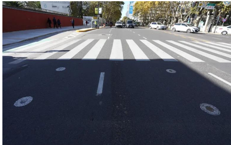
Imagen 1 - Magnetómetros sobre la cinta asfáltica.
