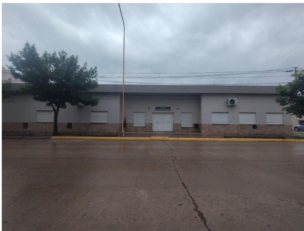
Fotografía 1: E.E.S.O.P.I “Colegio Corazón de Jesús”. Entrada Principal – San Carlos Centro, Santa Fe.
